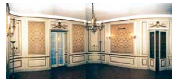
Le Salon d'honneur de la Croix-Rouge avant les travaux de rénovation...
